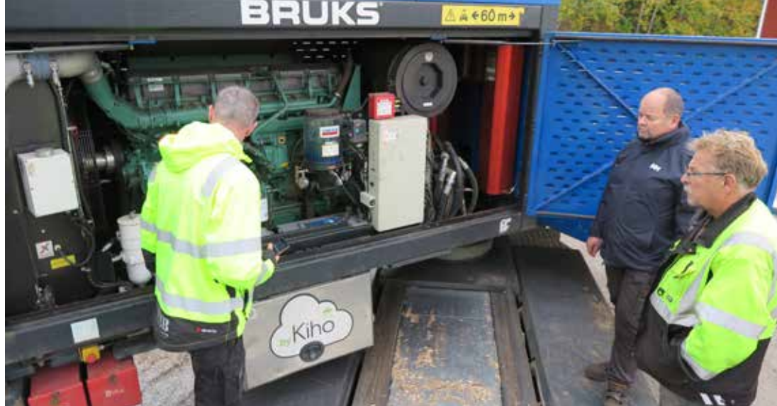
↑ Moottoritilassa on sähköä ja palokuormaa lähellä toisiaan, kun kone on käynnissä. Vasemmalta Sivebin Krister Lindström, Sawcenterin Björn Backman ja Flisapin Ari Lehtovirta.
